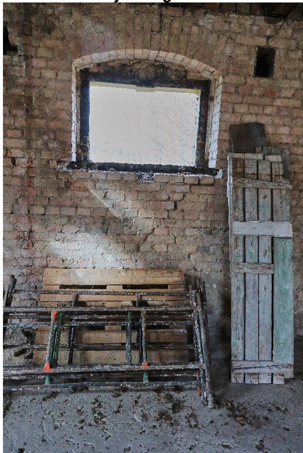
fot. Nr 1 – spękania ściany pod oknem
