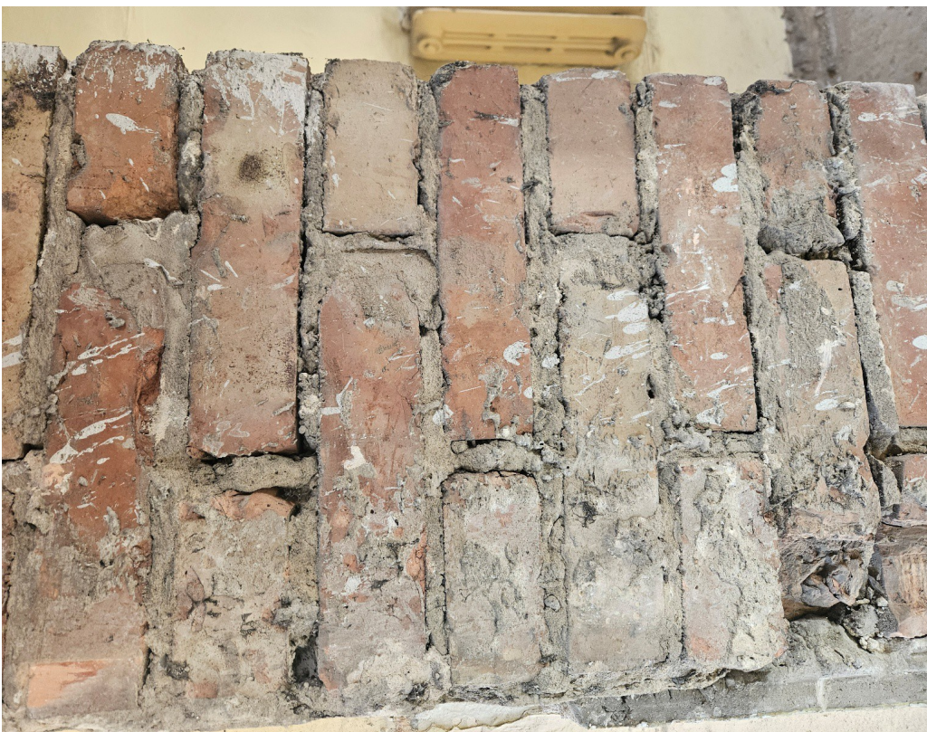
ubytków spoin w ścianach
