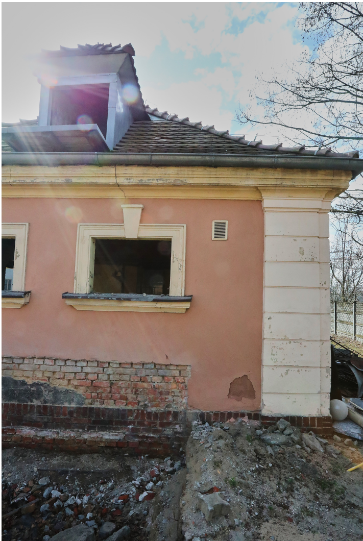
fot. Nr 3 – spękania nadproży od zewnątrz budynku
