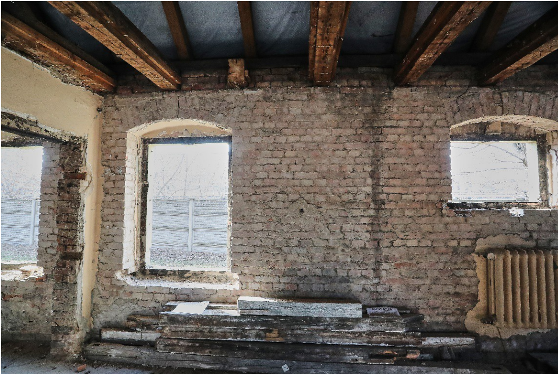
fot. Nr 2 – widok spękań nadproży od wnętrza budynku
