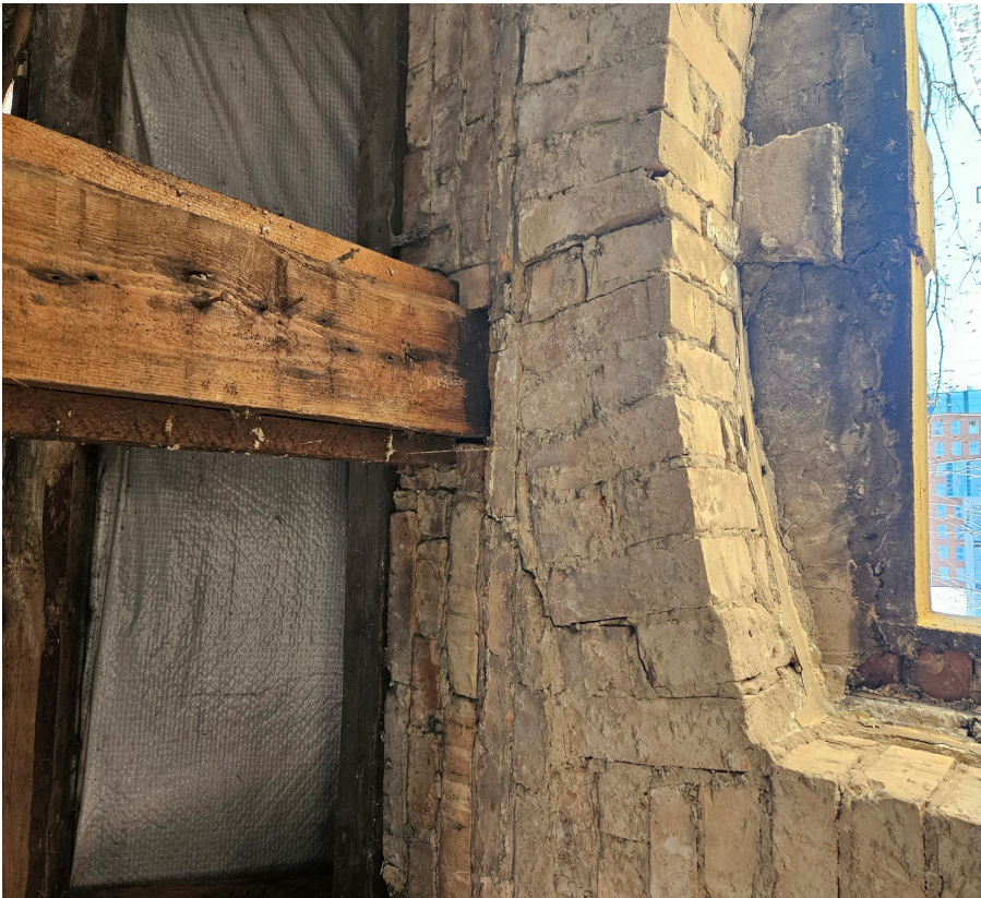
fot. Nr 4 – widok spękanego nadproża od wnętrza budynku
